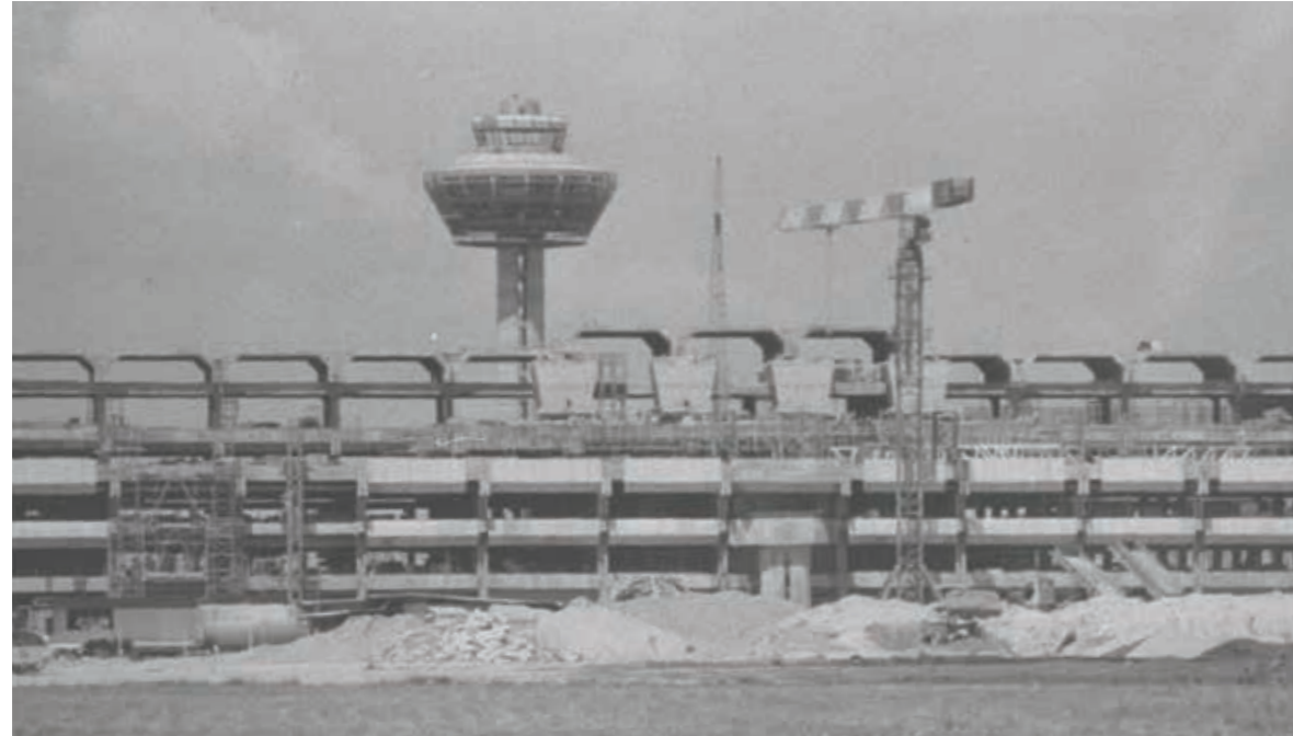
1980年樟宜机场在建设中（图片来源：Civil Aviation Authority of Singapore Collection，由新加坡国家档案馆提供）
