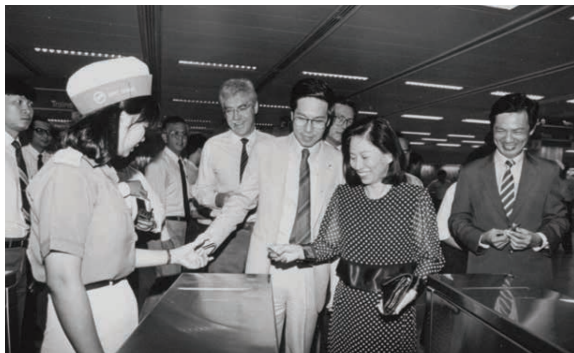
1987年11月，地铁首次从大巴窑通车至杨厝港，图为时任第二副总理王鼎昌与夫人通过地铁闸机。（图片来源：Ong Teng Cheong Collection，由新加坡国家档案馆提供）
