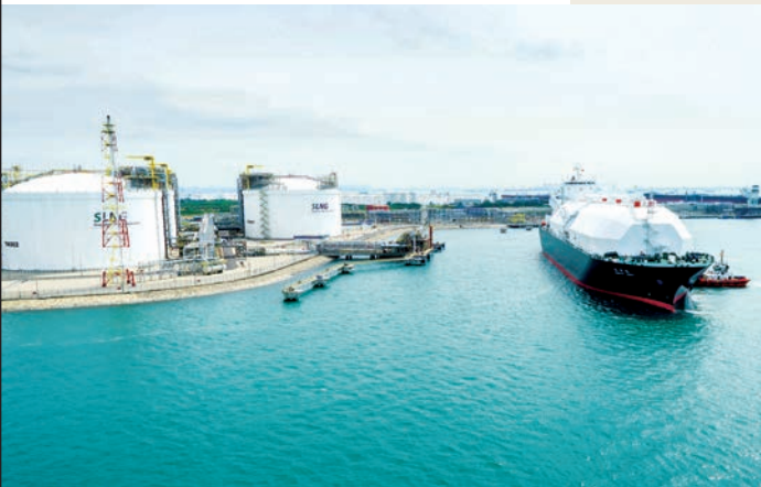
LNG Terminal. Courtesy of SLNG Corporation Pte Ltd.
